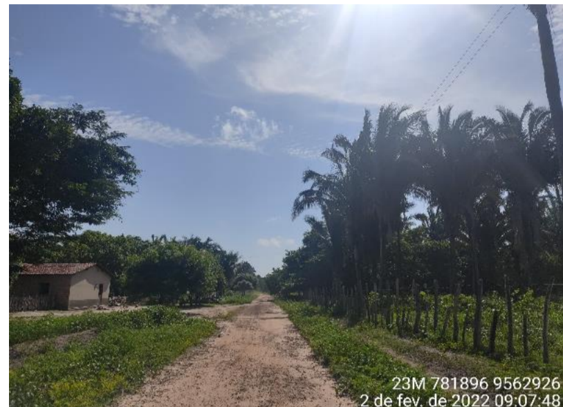
FOTO Nº 02 - TRECHO 01: COSTA - RIACHO SANTA MARIA
