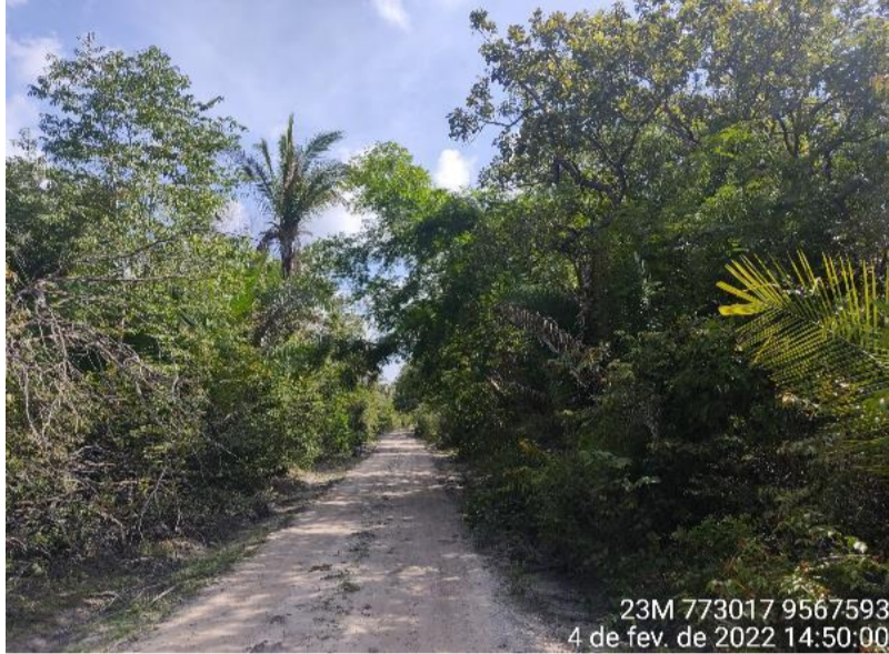
FOTO Nº 07 - TRECHO 04: BOM PRINCÍPIO - SÃO JOÃO
