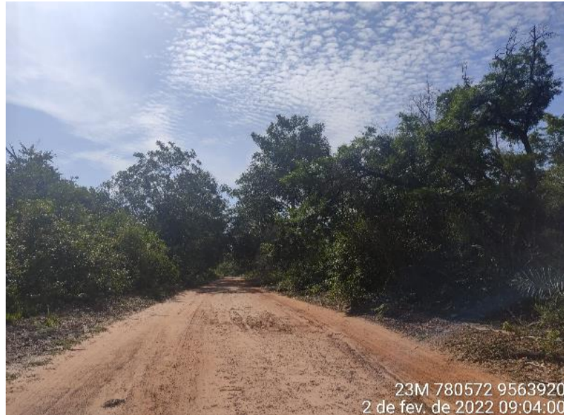
FOTO Nº 01 - TRECHO 01: COSTA - RIACHO SANTA MARIA
