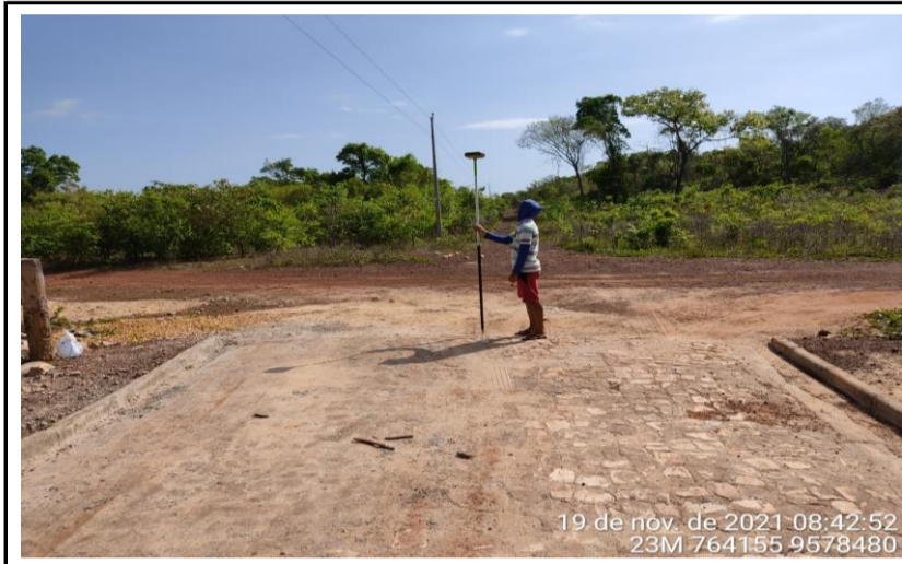
FOTO Nº 1 - RUA PROJETADA IX
