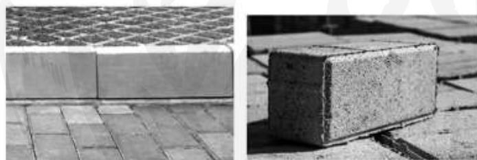
Foto 02: Meio fio de jardim e bloquete em concreto
